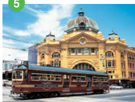
フリンドース・ストリート駅 1日25万人が利用するターミナル駅。1854年に国内初の駅として完成したエドワード王朝風の建築はメルボルンのシンボルとなっている
